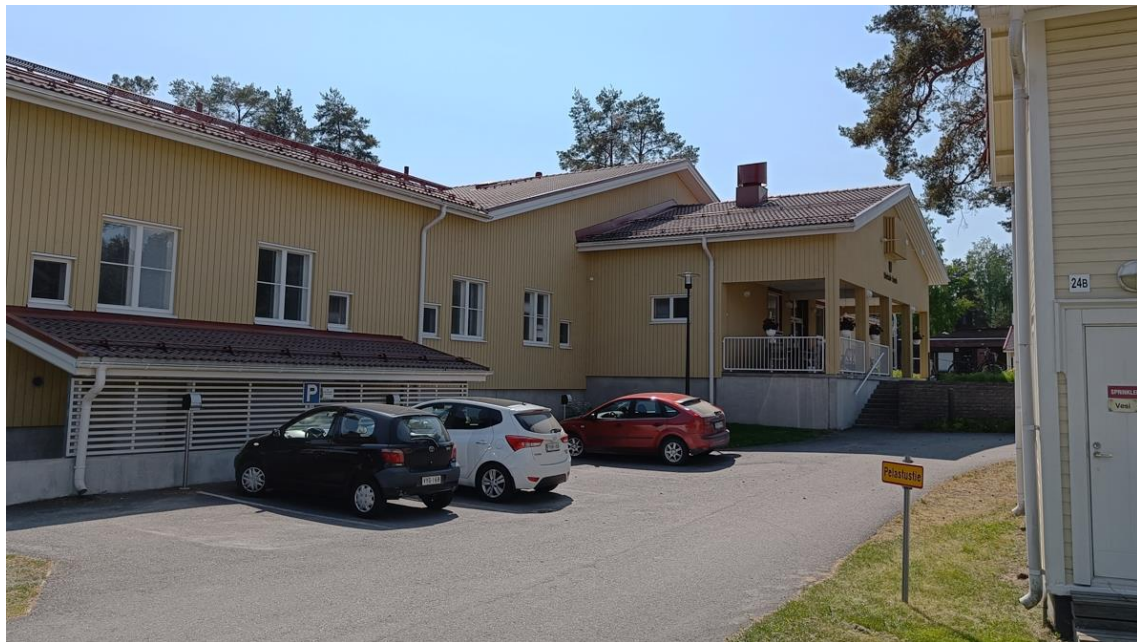
Kuva 25. Palvelukoti Kuusela pihan puolelta.
