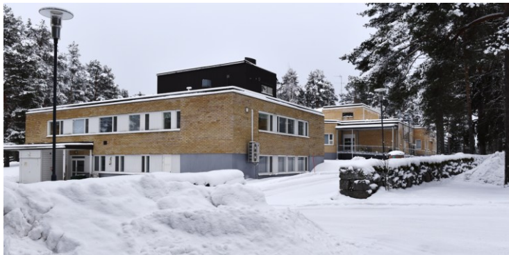
Kuva: Rantasalmen sosiaali- ja terveysasema kirkkopihan kiviaidan vieressä.
