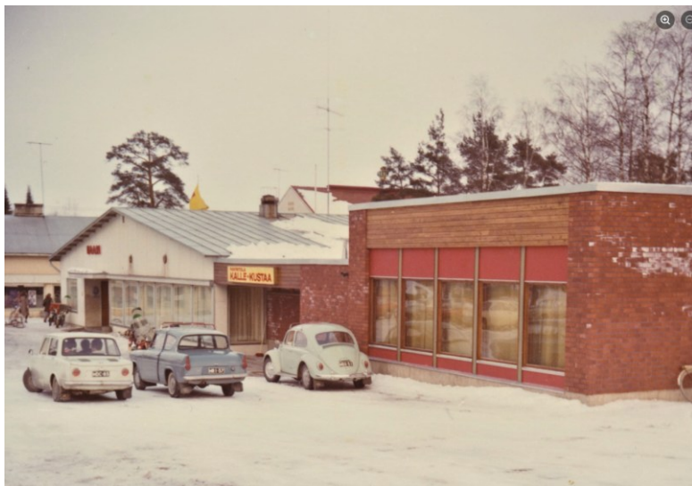
Kuva: Vaalea Shell-huoltoasema/baari -rakennus on 1950-luvulta ja punatiilinen ravintola-myymälä -laajennus 70-luvun vaihteesta. Vanha puoli, joka toimi myös linja-autoasemana, purettiin 1984 ja tilalle rakennettiin liikeyrakennus, johon säilynyt ravintolapuoli liitettiin. / Kuva Facebook-sivustolla Rantasalmen historiasta kiinnostuneet, julkaisija Matti Hartikainen 2.3.2021.
