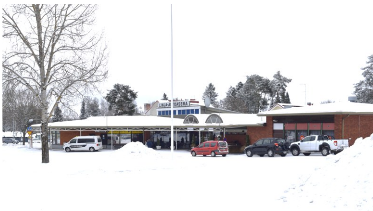
Kuva: Linja-autoasema -kylän alapuolella on 1980-luvulla rakennettu liikeyrakennus ravintolatiloihin ja oikealla vanhempi ravintola-myymäläsiipi, jonka tasakatto on muutettu aumakatoksi. Matkahuolto on lopettanut.
