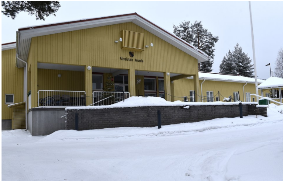
Kuva: Vanhan lääkärin talon pihapiiriin rakennettu uusi 20-paikkainen vanhusten palvelukoti palautti puurakentamisen harjun juurelle, josta vanhat pientalot purettiin 1970-luvulla tiilisten vanhustentalojen ja vanhainkodin tieltä.
