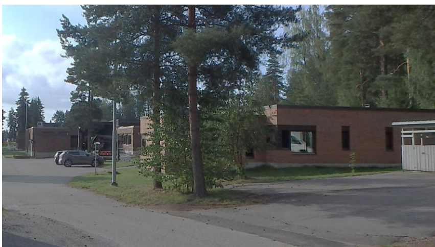
Kuva 8. Palvelukeskus Mäntylä oikealla, taaempänä terveyskeskuksen sairaala.
