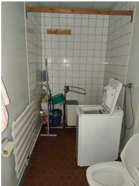
Kuva 20 Wc-tilan pintarakenteet ovat todennäköisesti alkuperäiset.
