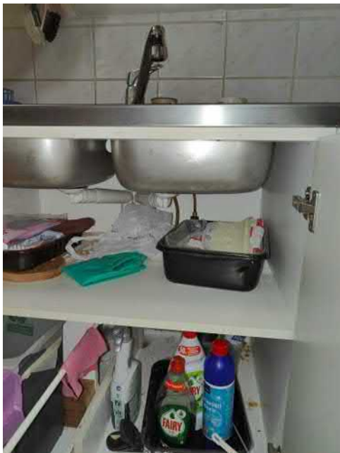
Kuva 35 Allaskaapeissa ei havaittu vuotoja.
