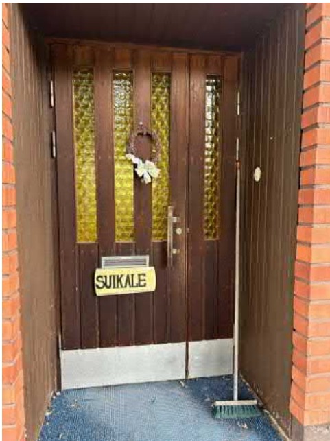
Kuva 13 Sisäänkäyntisennyksissä olevat ulko-ovet ovat alkuperäiset ja säilyneet paremmin, koska ne ovat olleet säältä suojassa paremmin.
