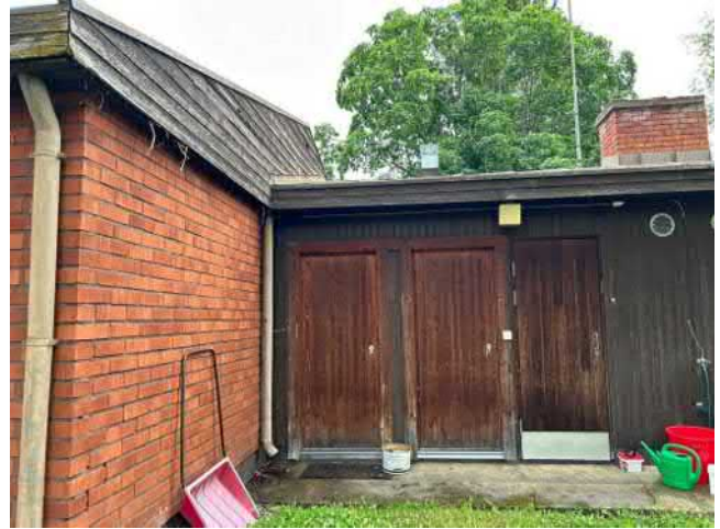
Kuva 12 Varaston ovet ovat alkuperäisiä puuovia.
