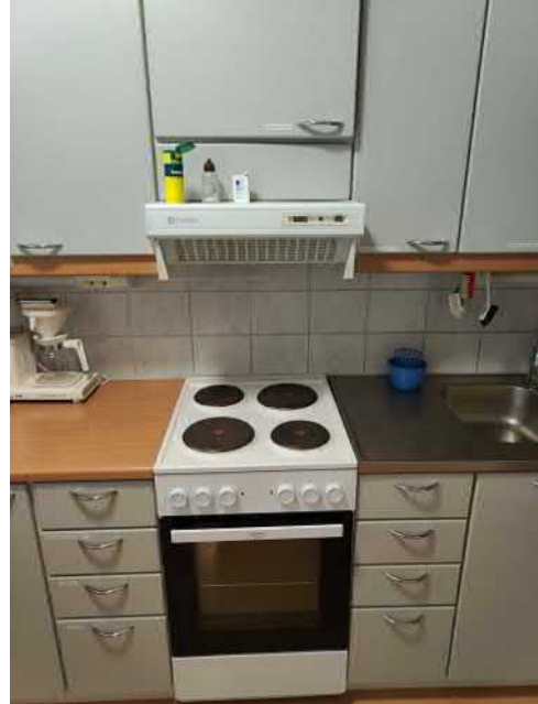
Kuva 38 Liesikuvut aktiivihiihitsuodatimella.
