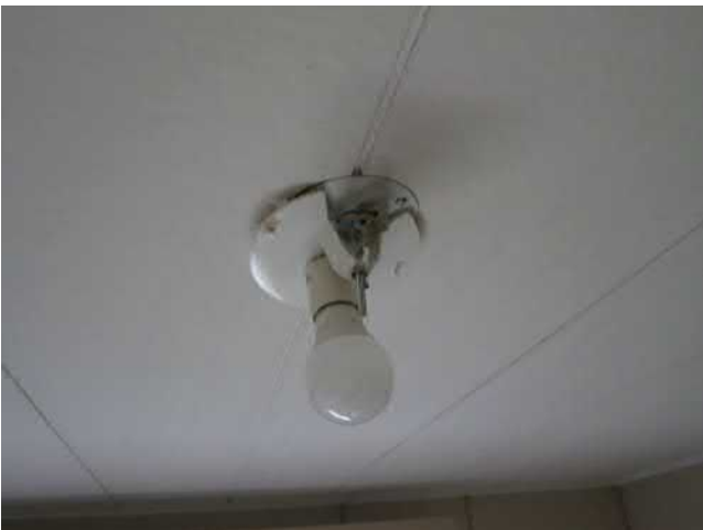
Kuva 47 Asunnon kattovalaisin, "sokeripala"liittimet. Nykyisin vaaditaan maadoitetut valaisinpistorasiat.
