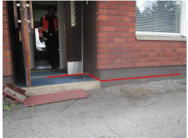
Kuva 6 Lattian yläpinnan taso suhteessa maanpintaan
