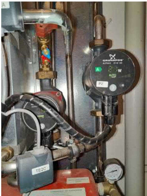
Kuva 28 Lämmönjakokeskus ja pumput uusittu.
