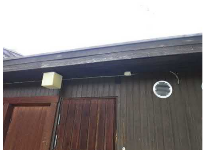
Kuva 48 Ulkovalaisin, alkuperäinen vuodelta 1971. Kellastunut kupu.
