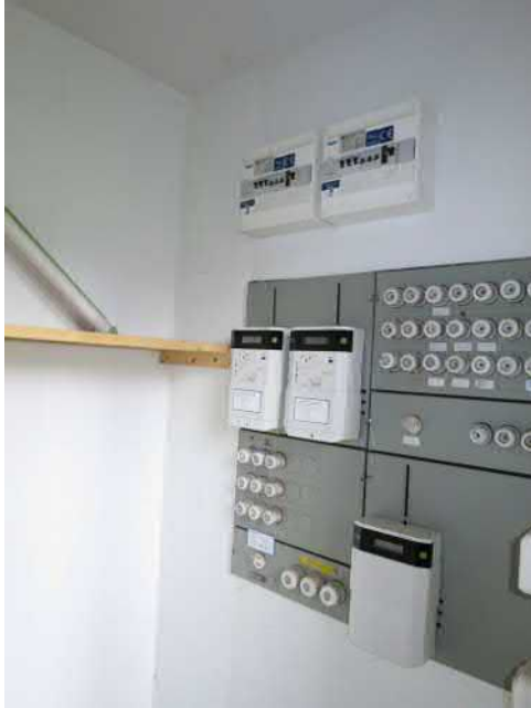
Kuva 40 Sähköpääkeskus vuodelta 1971
