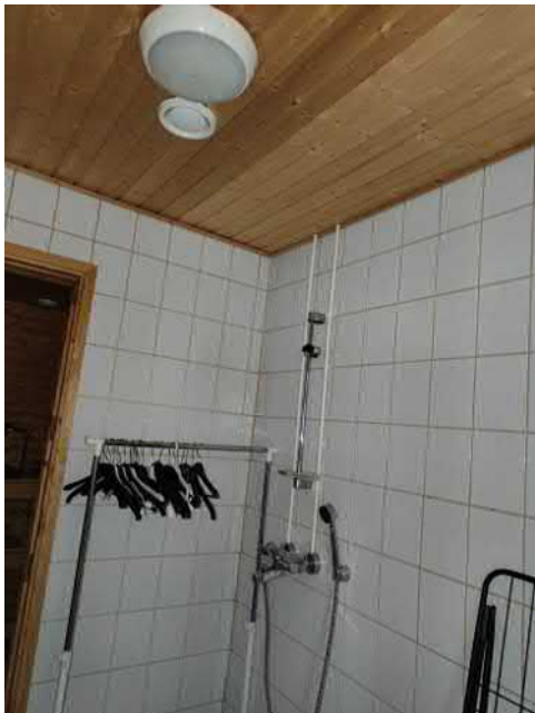
Kuva 39 Poistoventtiilejä uusittu.
