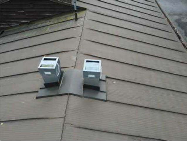
Kuva 37 Huippuimurit vesikatolla.
