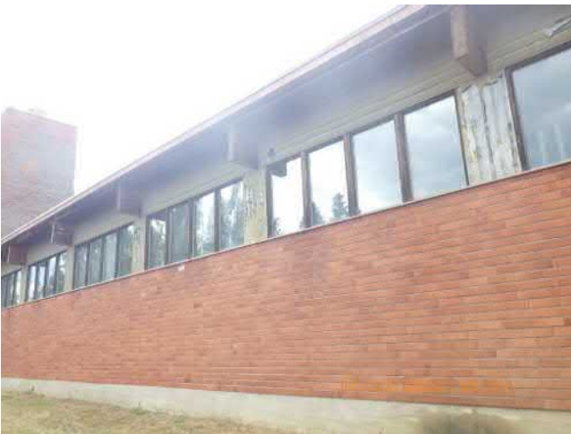
Kuva 28 Ikkunoiden puuosien maalipinta on haalistunut.
