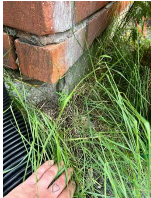
Kuva 8 Sokkelin nurkka on lohennut pois.
