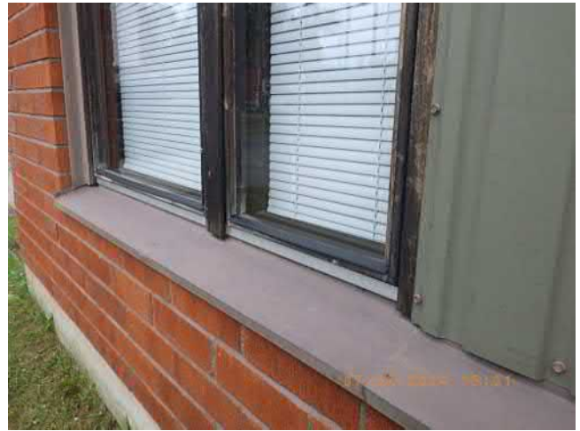
Kuva 27 Vesipeltien kaltevuus on riittävä.
