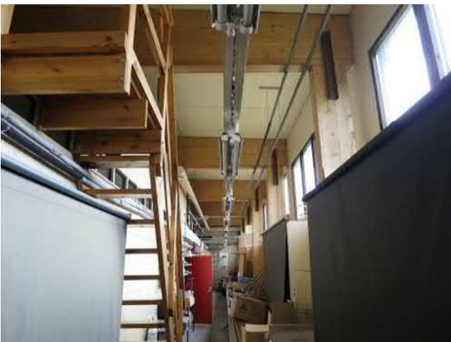
Kuva 76 Valaisipustuskisko. Huoltotilat, takatila
