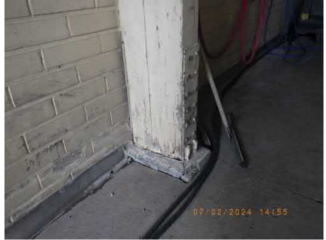
Kuva 14 Anturakaulusten liittymissä on rakoja.
