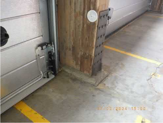
Kuva 13 Pilarin anturakalus.
