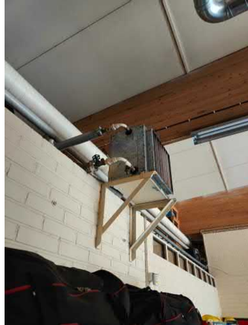
Kuva 46 Hallin kiertoilmapuhaltimet ja venttiilit havaintojen perusteella alkuperäiskuntoiset.
