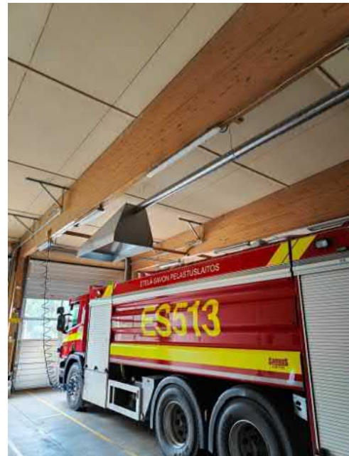
Kuva 34 Vesikaton/yläpohjan pääkannattajana ovat liimapuupalkit.
