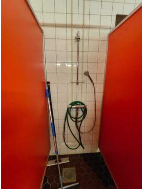
Kuva 55 Osa vesi ja viemärikalusteista uusittu.
