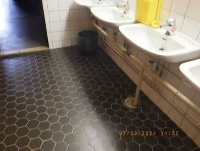
Kuva 39 Lattialaatoitu on todennäköisesti alkuperäinen.
