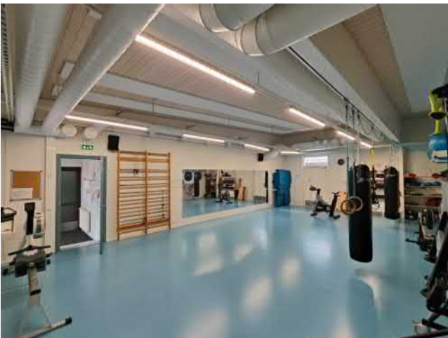
Kuva 72 Yleiskuva kanavat ja päätelaitteet.
