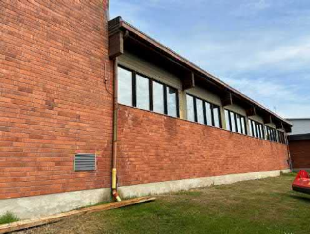
Kuva 17 Yleiskuva paloaseman takaosasta
