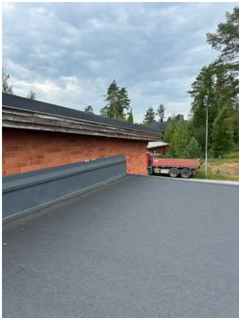
Kuva 33 Räystäsrakenteiden puuverhoilunosat ovat huonokuntoisia.
