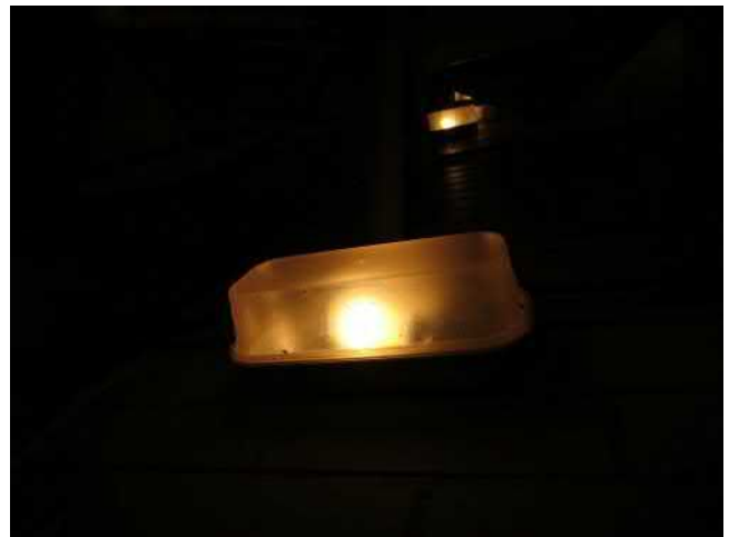
Kuva 87 Tornin kierreportaan valaisin seinässä, hehkulamppuvalaisin.
