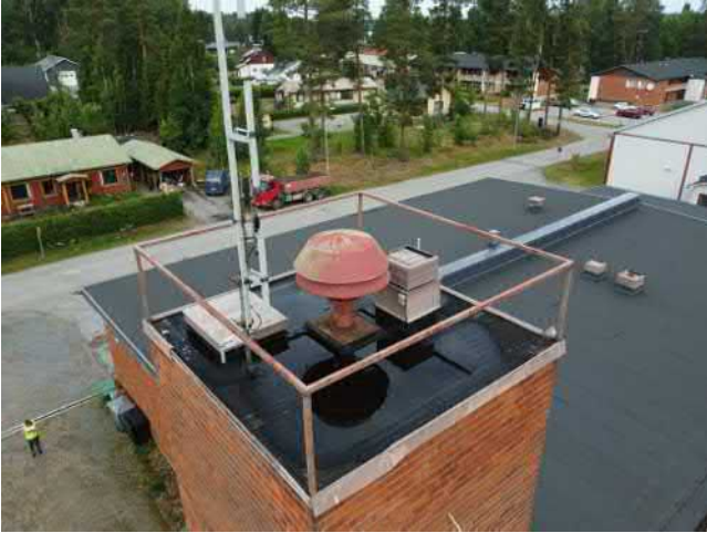
Kuva 62 Vanhan osan huippuimurit aistinvaraisesti arvioiden alkuperäisiä ja käyttökänsä päässä.
