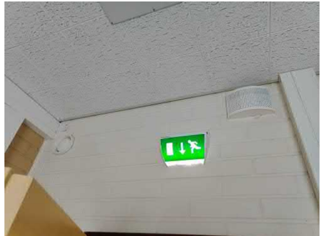
Kuva 69 Yleiskuva kanavat ja päätelaitteet.
