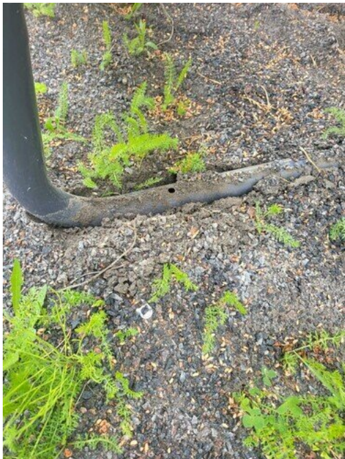
Kuva 25 Maa-ankkureita uupuu.
