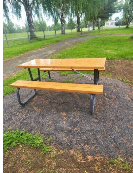
Kuva 24 Maa-ankkureita uupuu.
