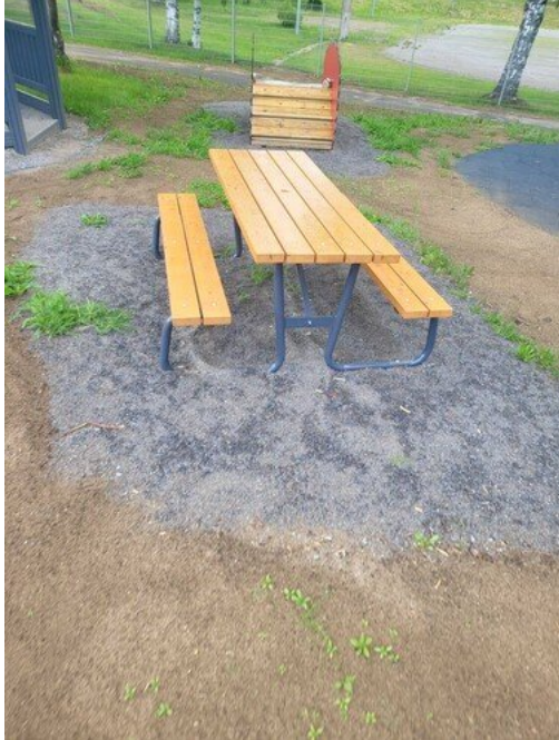
Kuva 23 Maa-ankkureita uupuu.
