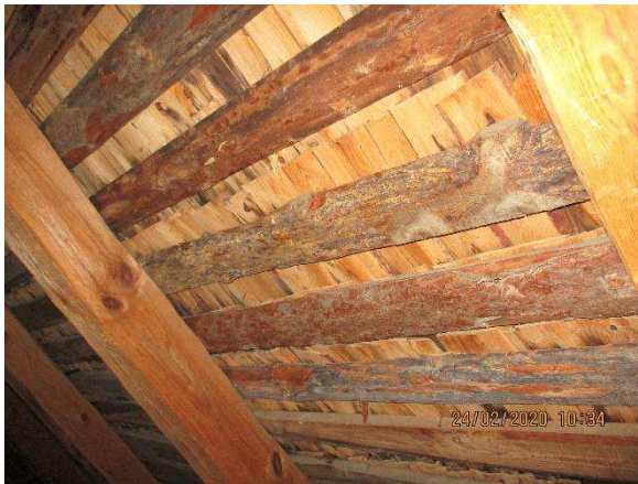
Kuva 35. Peltikatteen alla oleva pärekate.
