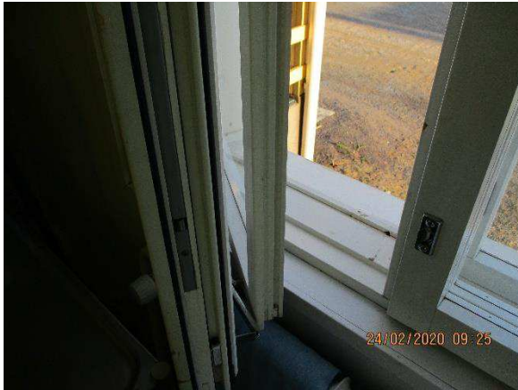
Kuva 24. Uusittuja MSE-ikkunoita 1. kerroksessa.
