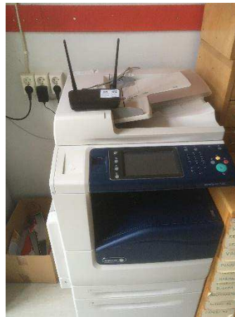
Kuva 85. Kiinteistön langattoman verkon laitteita.
