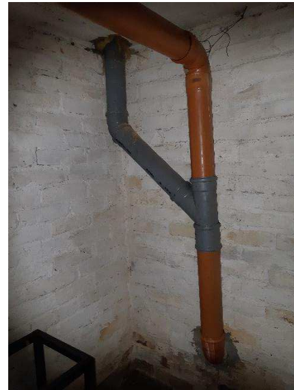
Kuva 57. Näkyvässä olevaa viemäriä rakennuksen kellarikerroksessa.
