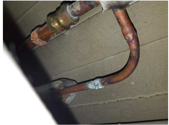
Kuva 59. Sinkkikatoa messinkijuotoksessa.
