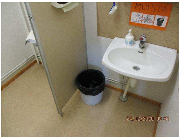
Kuva 38. Miesten Wc-tila 1. kerroksen aulan vieressä.
