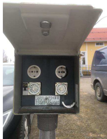
Kuva 74. Autolämmityspistorasiat.
