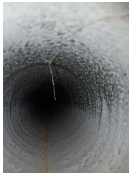
Kuva 63. Likaantunut poistoilmakanava.
