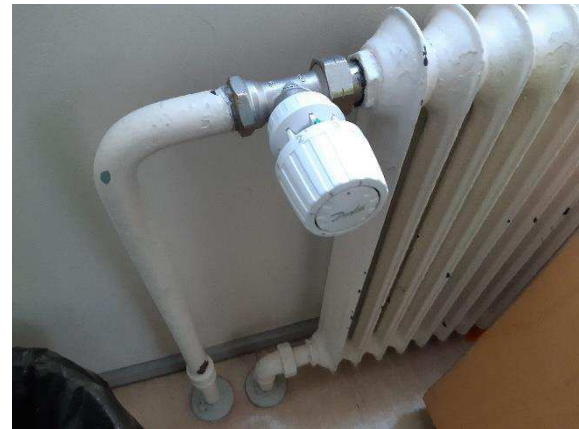
Kuva 55. Vaihdettu patteriventtiili.
