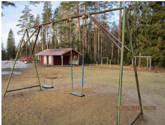
Kuva 8. Kiikku. Metallirungon maalipinnassa kulumaa.
