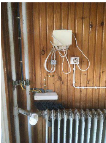
Kuva 82. Antenniverkon antennivahvistin.
