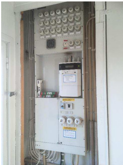
Kuva 67. Kiinteistön sähköpääkeskus.
