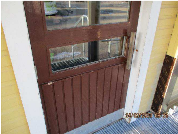
Kuva 27. Keittiön päädyssä oleva etupihan puoleinen ulko-ovi.
