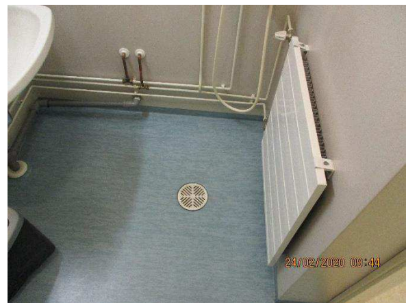
Kuva 39. Opettajien huoneen vieressä oleva Pesuhuone/Wc-tila, 1. krs.
