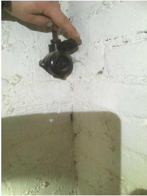
Kuva 71. Kellarikerroksen nollaluokan pistorasia.
