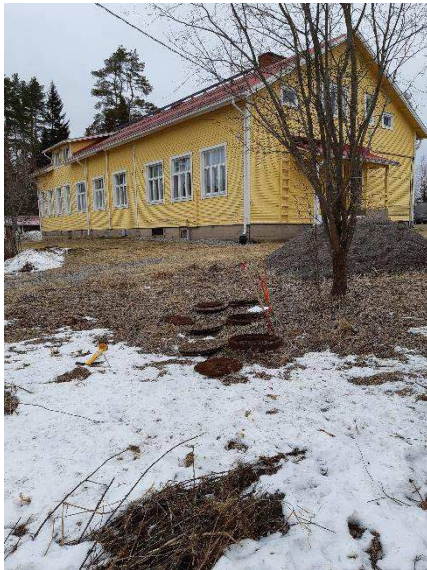
Kuva 56. Saostuskaivot rakennuksen pihalla
