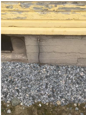
Kuva 65. Puutteellinen kaapeli suojaus seinällä.
