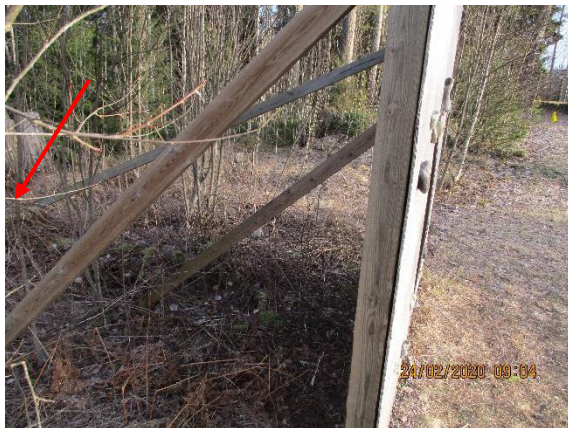
Kuva 10. Kiipeilyseinän edestäpäin katsottuna oikeanpuoleinen (kuvassa takimmainen) vinotuki irronnut kiinnityksestään. Korjattava välittömästi.
