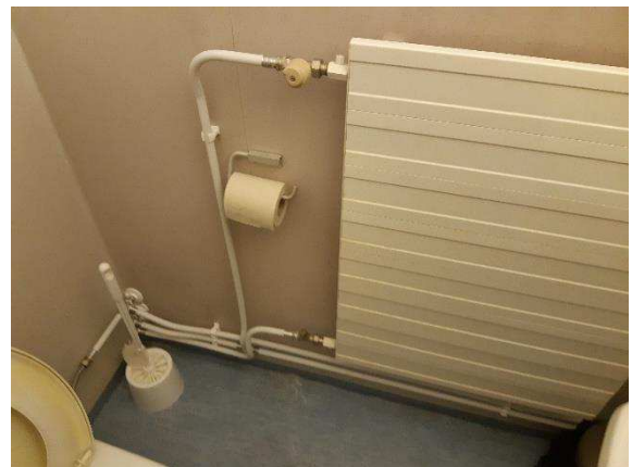
Kuva 61. Lämpimän käyttöveden kiertoon asennettu patteri.
