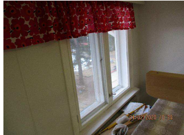
Kuva 25. Yläkerran vanhempi MS-ikkuna.
