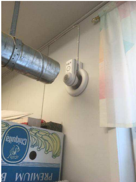
Kuva 69. Kuivauskaapin kanavapuhallin.
