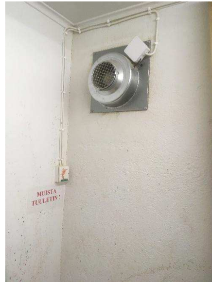
Kuva 70. Käsityötilan kanavapuhallin.
