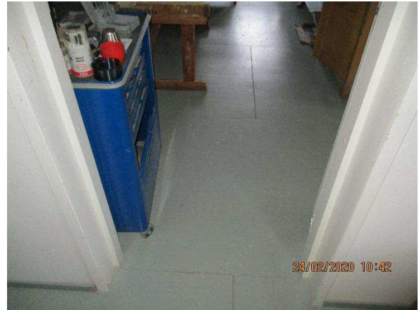
Kuva 18. Teknisen tilan lattia-/välipohjarakennetta 2. kerroksessa.
