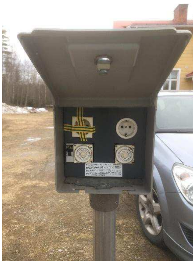
Kuva 73. Autolämmityspistorasiat.
