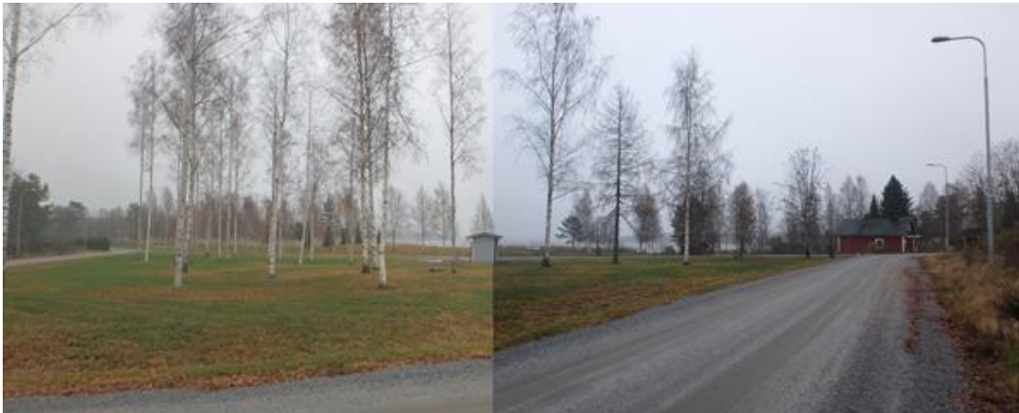
Kuva: Näkymä Kulmatieltä Rauanvedelle. Kulmatien ja kevyen liikenteen reitin väliin jäävällä viheralueella sijaitsee jätevedenlinjapumppaamo sekä siihen liittyvä putkilinjasto.
